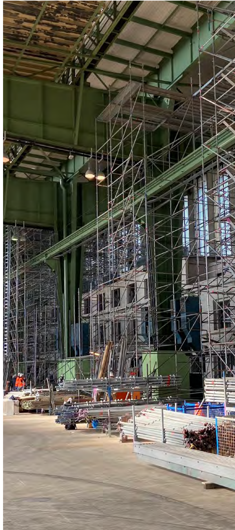
Hangarsanierung im Hangar 7 © Angelika Schaal, Tempelhof Projekte GmbH
